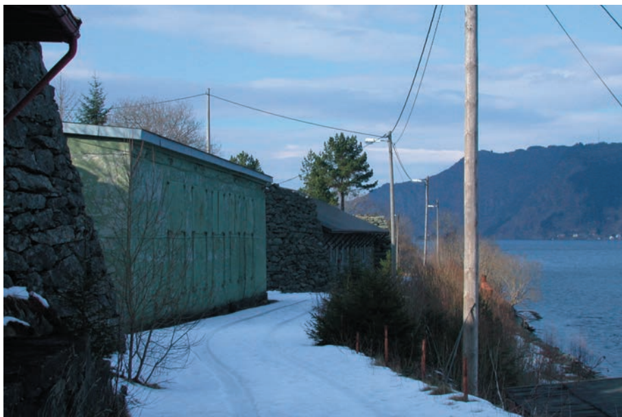
Parti fra Garnes leir, med eksisterende bygninger. Mellom og i bakkant av bygningene kan man se en høy og kraftig steinmur.
